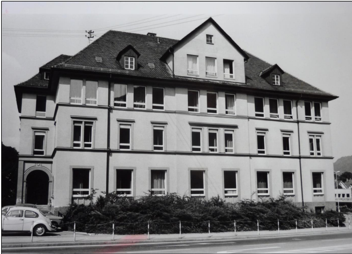
Das renovierte Alte Gymnasium um 1985, als die neue Schubart-Realschule dort noch ansässig war, Stadtarchiv Geislingen
