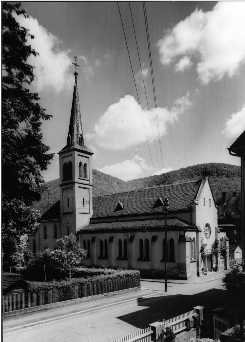
Die neugotische katholische Kirche St. Sebastian in der Bismarckstraße, erbaut in den Jahren 1865/66, nach Plänen des Wiener Dombaumeisters Friedrich Schmidt, Stadtarchiv Geislingen
