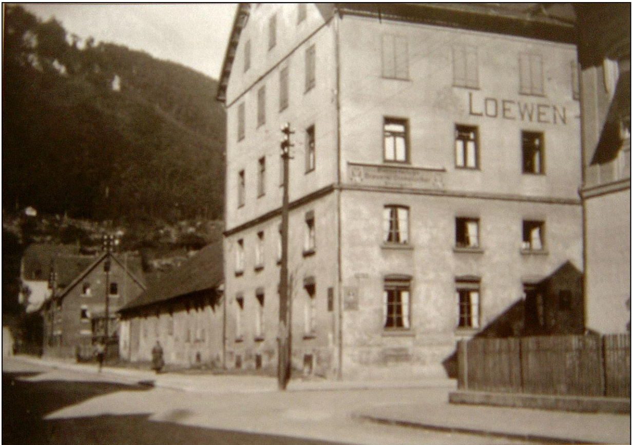
Die einstige Löwenbrauerei an der Ecke Schillerstraße/Römerstraße in den 1920er Jahren, Stadtarchiv Geislingen
